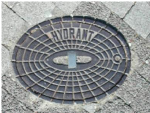
Abdeckung eines Unterflurhydranten
