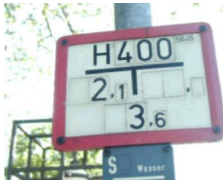
Hinweisschild eines Unterflurhydranten
